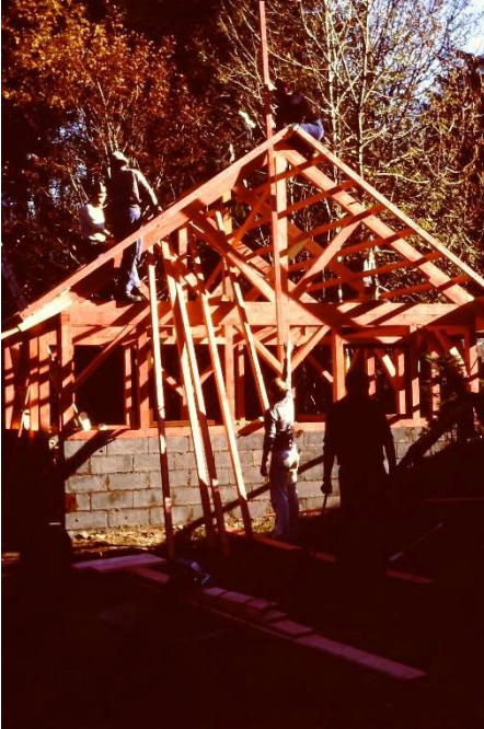
Bau der Materialhütte 1982
