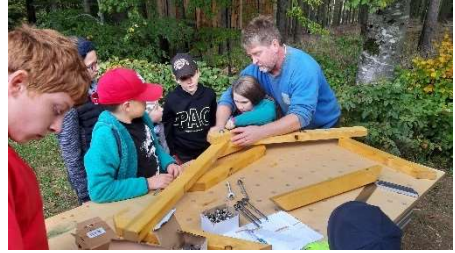
Bau einer neuen Sitzgruppe für den Aussenbereich
